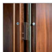
pevné bezpečnostné trny (B) TYP P
