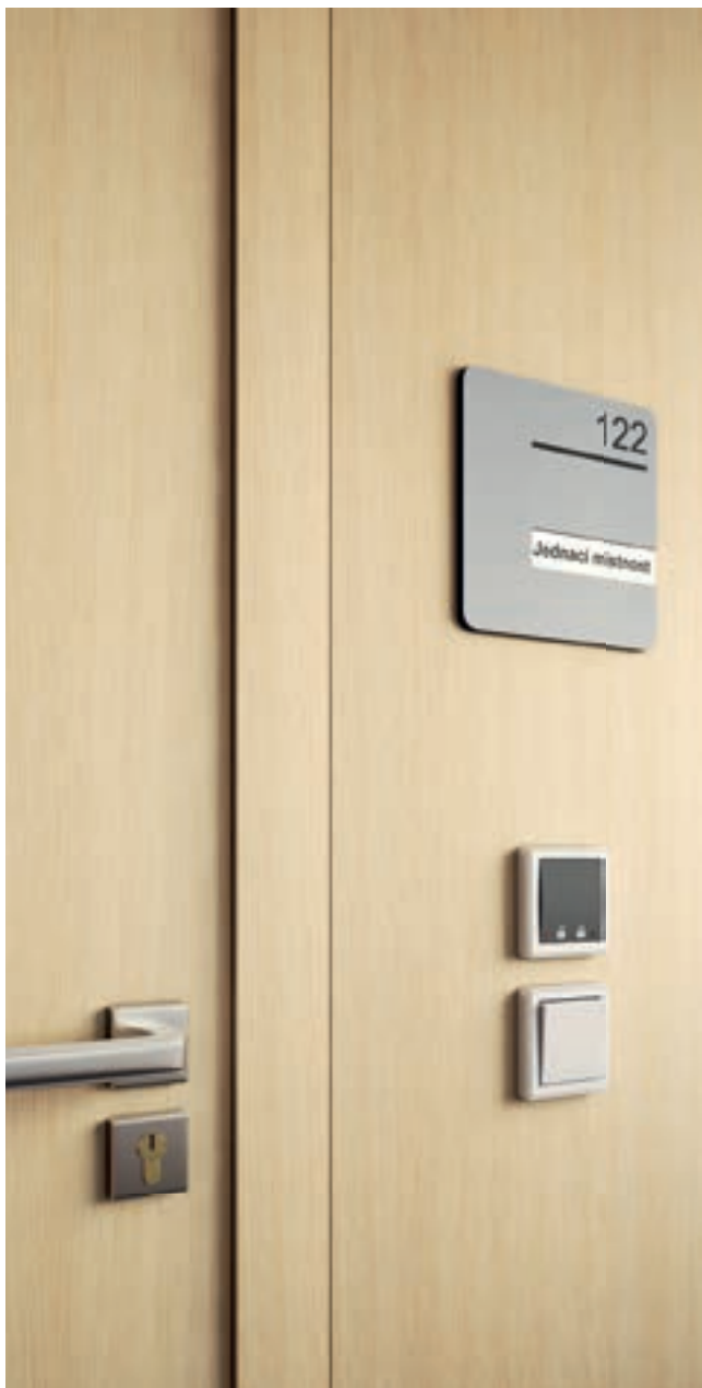
Dřevěný panel osazený vypínačem a přístupovým systémem
